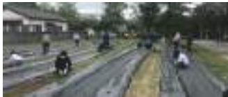
▲防草シート張り作業
