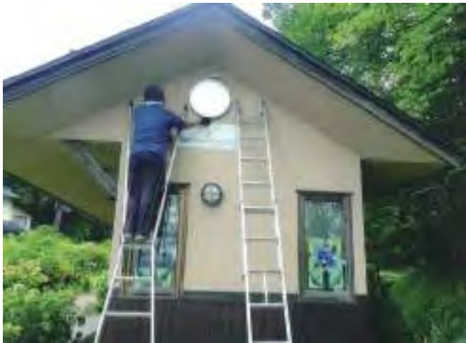
▲土合館公園のトイレ
